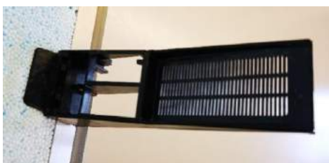
Figure 9 - Equerre de sous-face fixée sur le rail
