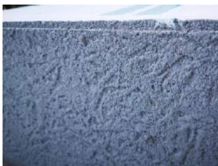
Figure 5 - Finition primaire de protection
